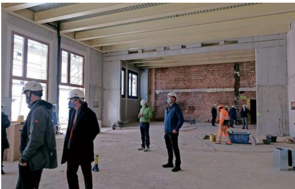
Im Rohbau des Kultursaals; im Hintergrund wird die Bühne entstehen.
