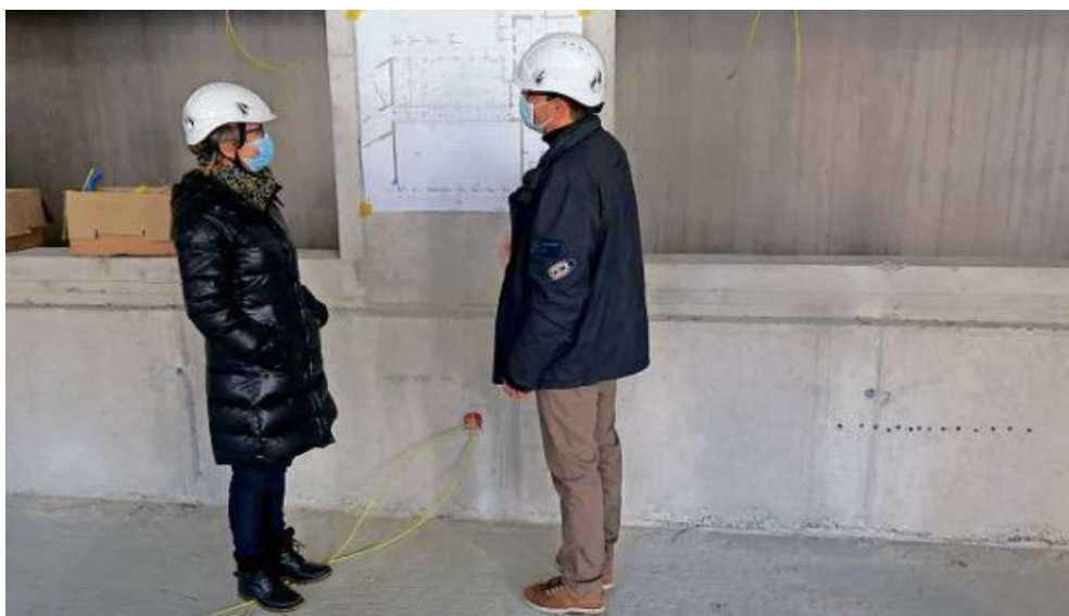
Mit Schutzhelm und Schutzmaske führen Schulratspräsidentin Elisabeth Sigron und Architekt Joos Gredig durch die Baustelle.
